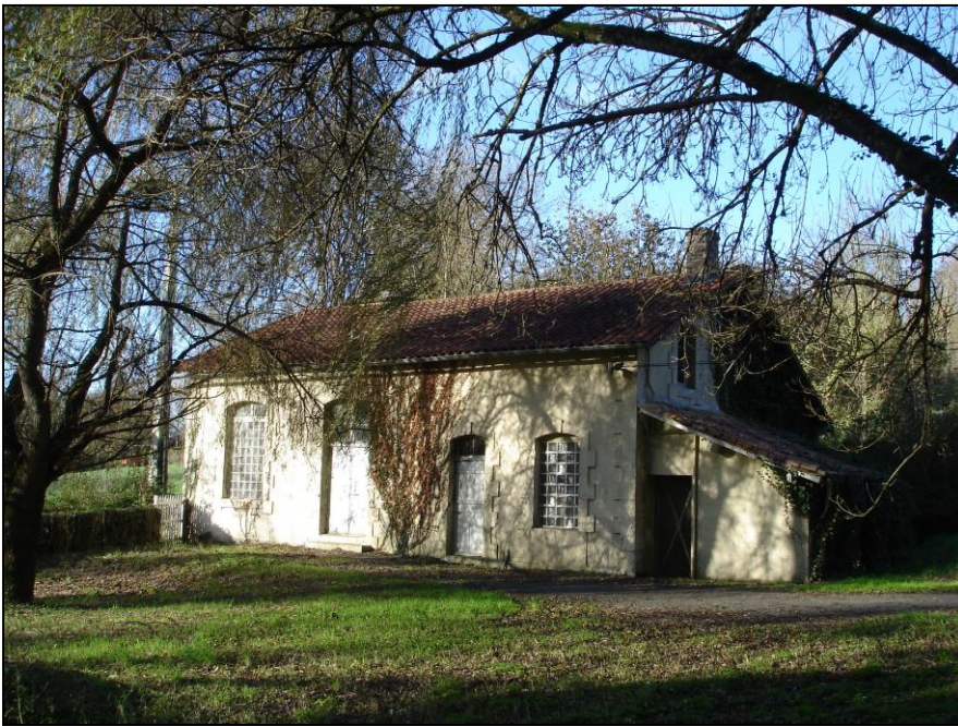
Photo 2 : Bâtiment d'exploitation du captage de la Chancelée
